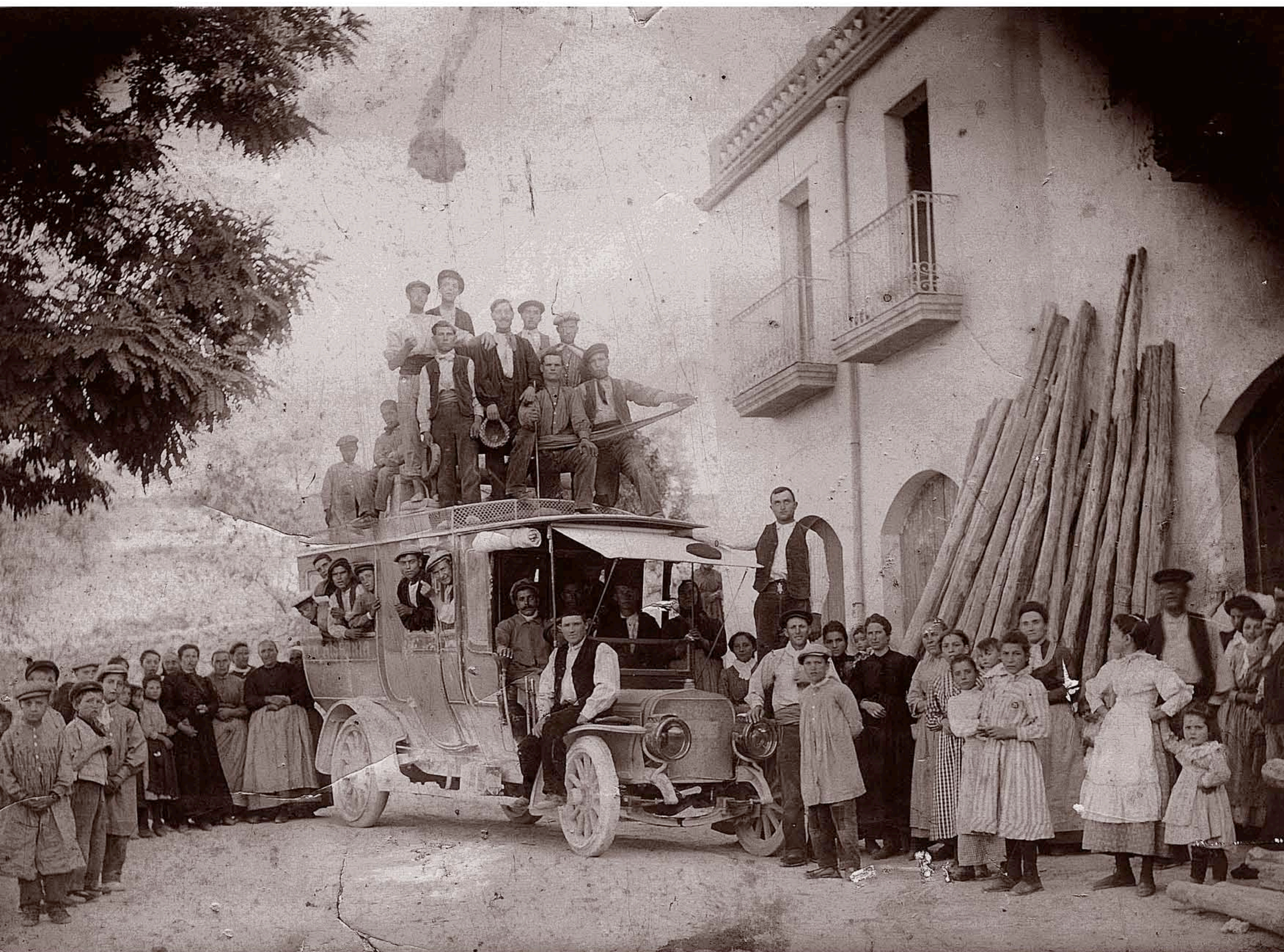
ARRIBADA DEL COTXE DE LÍNIA. ULLDEMOLINS
